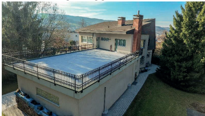
Rückansicht – Terrasse über Hallenbad
